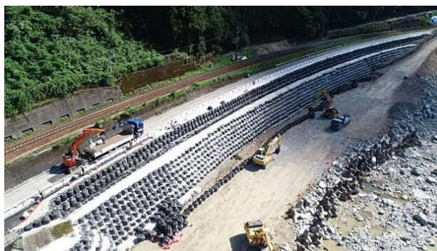
河川内の施工ヤード確保
