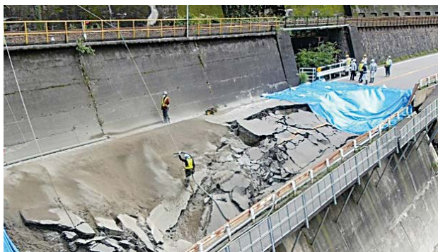
JR高山本線並行被災区間の法面復旧作業
