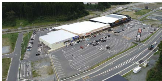
共同利用街区に立地した大型商業施設
