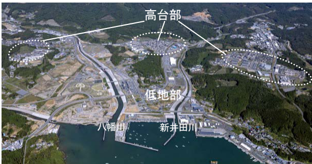
事業完了後の状況（令和2年10月撮影）
