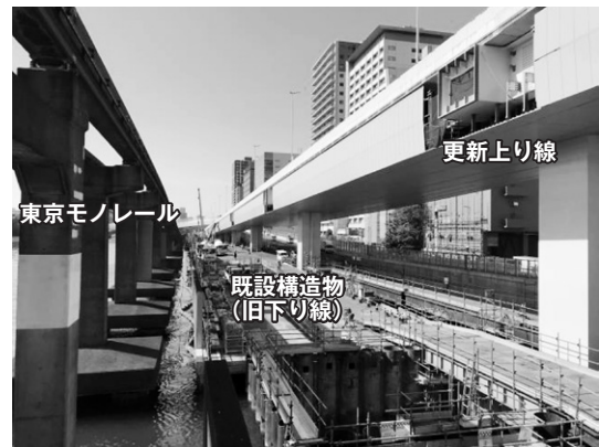
既設構造物撤去及び新設橋脚工の施工状況
