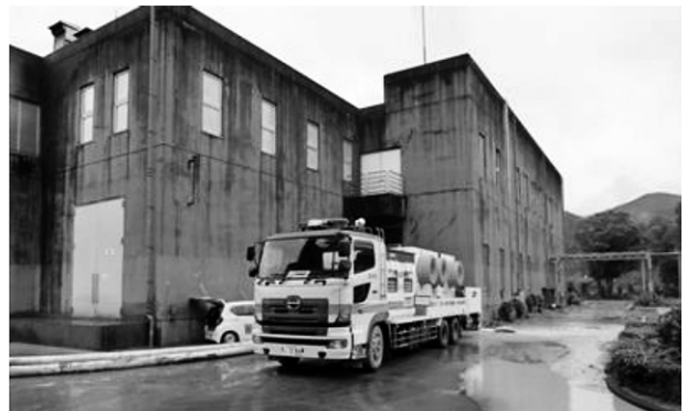
人吉浄水苑浸水状況と排水作業状況
