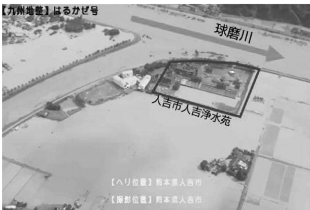
人吉浄水苑浸水状況（航空写真）
