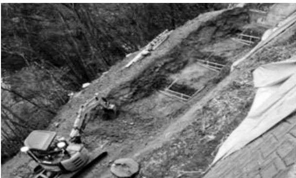
写真-2 ICT建機による掘削作業
