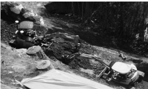
写真-3 ICT建機と従来建機の併用
