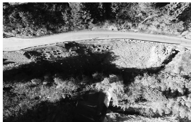
写真-1 工事施工箇所
