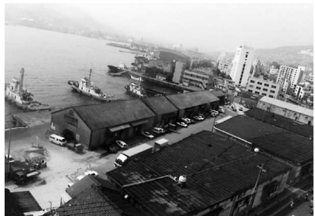
写真-1 昭和終わり頃の長崎港常盤地区
