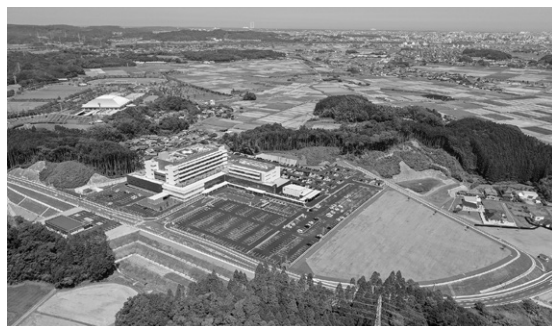
写真-2 宮崎市防災支援拠点完成写真
