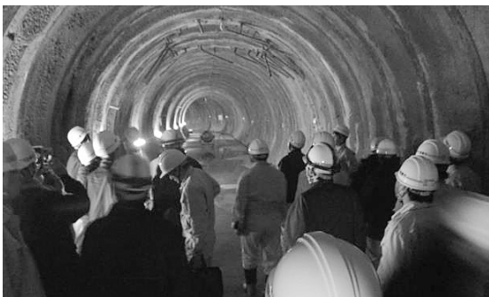
写真-4 現場研修の様子（地下水排水用トンネル）
