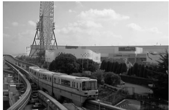
写真-3 都市モノレール整備事例 (大阪モノレール)
