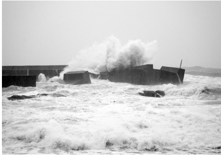
写真-1 和歌山県串本町・動鳴気漁港防波堤の被災
