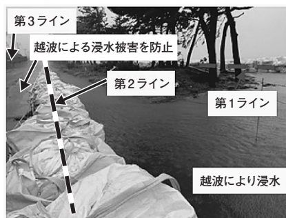
写真-3 土嚢を3列に配置し浸水を防止（台風第19号）
