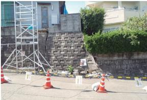
写真-2 擁壁被害状況
