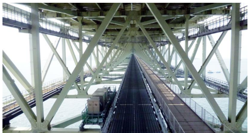
中央点検通路
