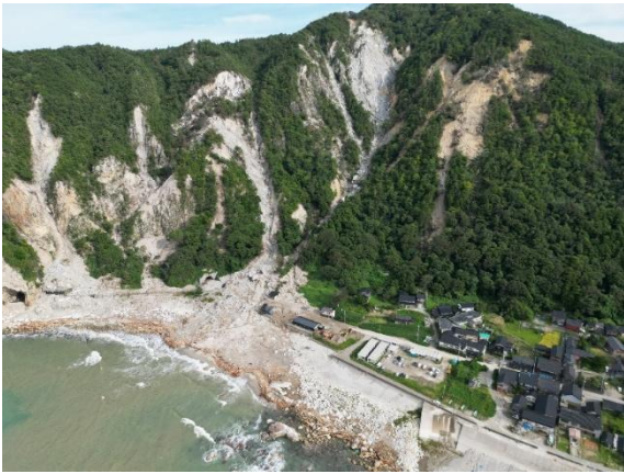
曾々木地区の斜面全景（崩壊時）
