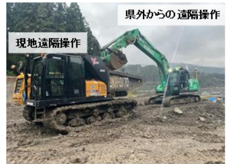
危険が伴う災害復旧工事での遠隔施工状況
