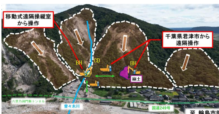
落石の危険性を伴う地すべり対策工事 (石川県輪島市曾々木地区)
