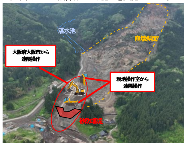
崩壊土砂内での砂防工事 (石川県輪島市市ノ瀬地区)
