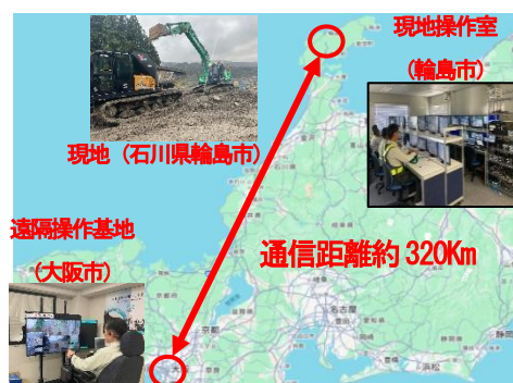
県内外からの遠隔施工
