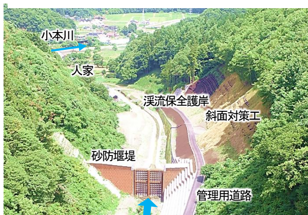
【 施設整備状況 】
