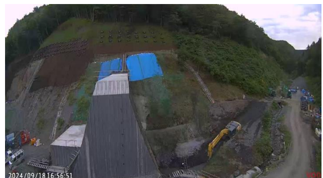
カメラ②(堰堤上流側)
