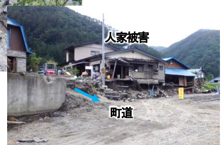
【 被災状況写真 】
