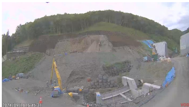
カメラ①(堰堤下流側)
