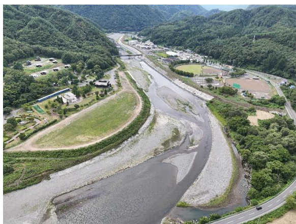
完成写真(小本川乙茂工区)
