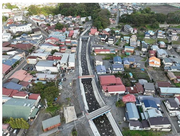
完成写真(清水川工区)
