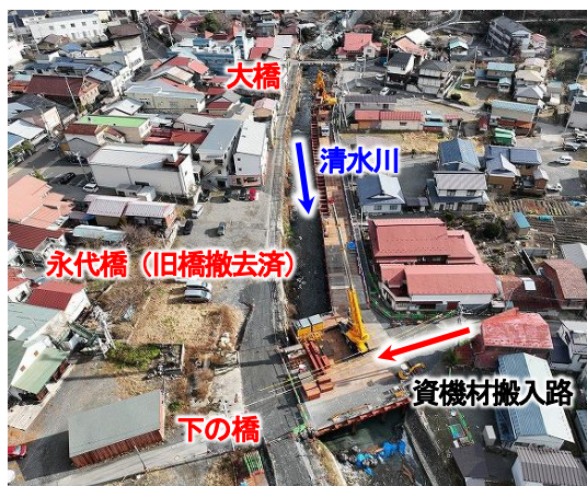
清水川工区 仮設構台設置状況(大橋施工時)
