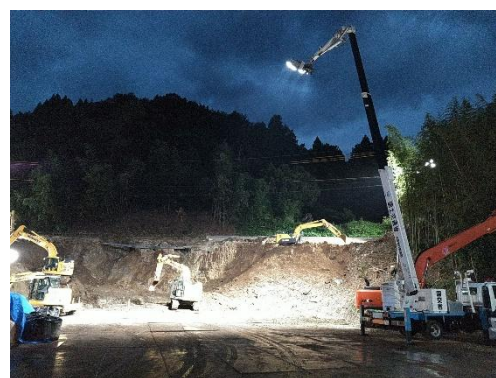
施工時の状況(夜間)
