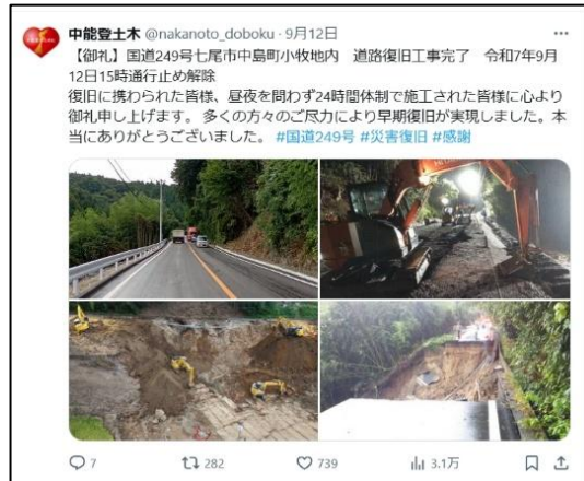
中能登土木総合事務所より発信状況
