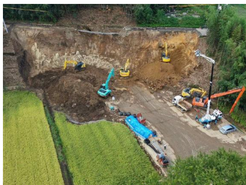
施工時の状況
