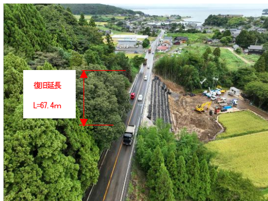
応急本工事完成写真(上空)
