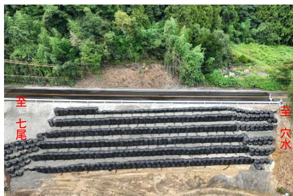
応急本工事完成写真(正面)
