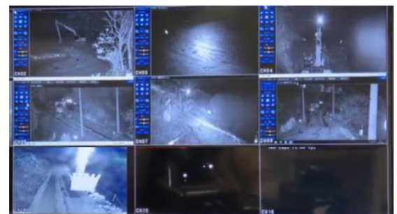
夜間作業における操作モニター
