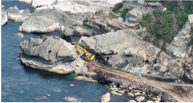
緊急復旧道路 工事中の様子
