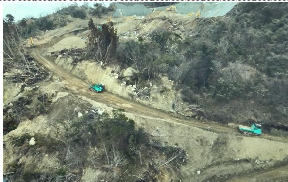
無人化施工による地すべり頭部排土
