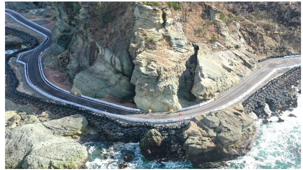
完成した緊急復旧道路
