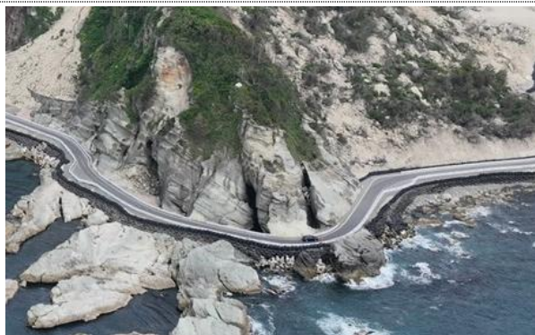
完成した緊急復旧道路
