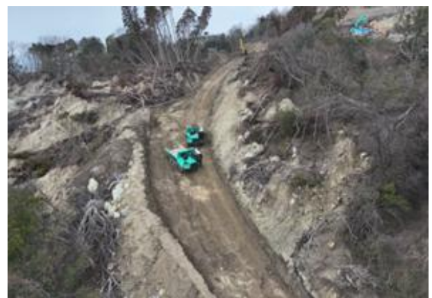
自動操縦の不整地運搬車のすれ違い
