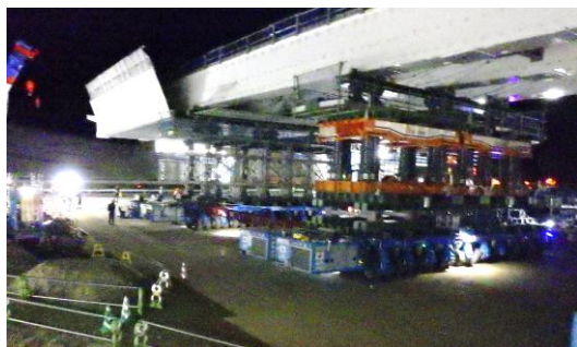
長沢ランプ橋架設状況①
