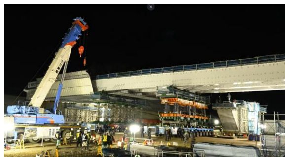
長沢ランプ橋架設状況②
