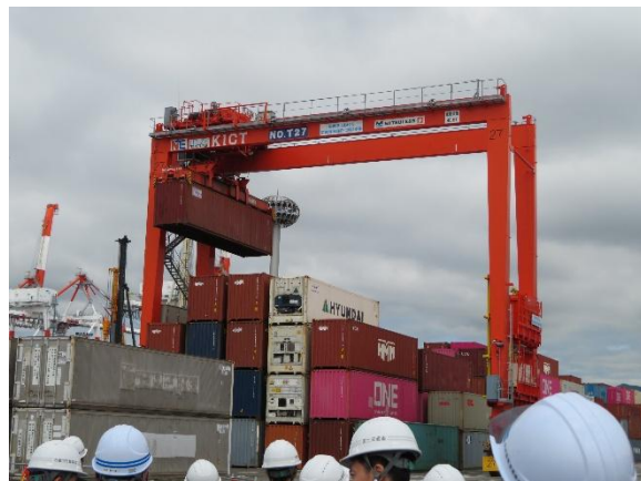
水素エンジン発電機換装 RTG の稼働状況
