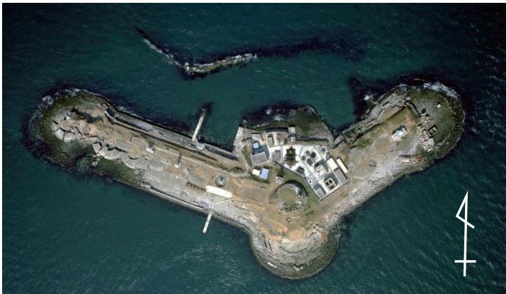
図-2(a) 第二海堡護岸の整備前の状況
