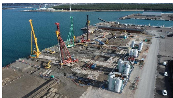
▲深層混合処理工法による施工状況
