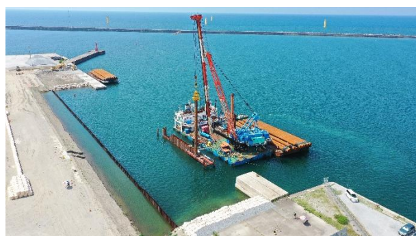
▲鋼管矢板の打設状況
