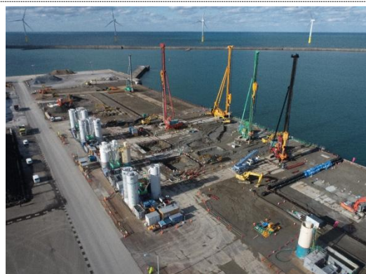
■地盤改良工事の施工状況
