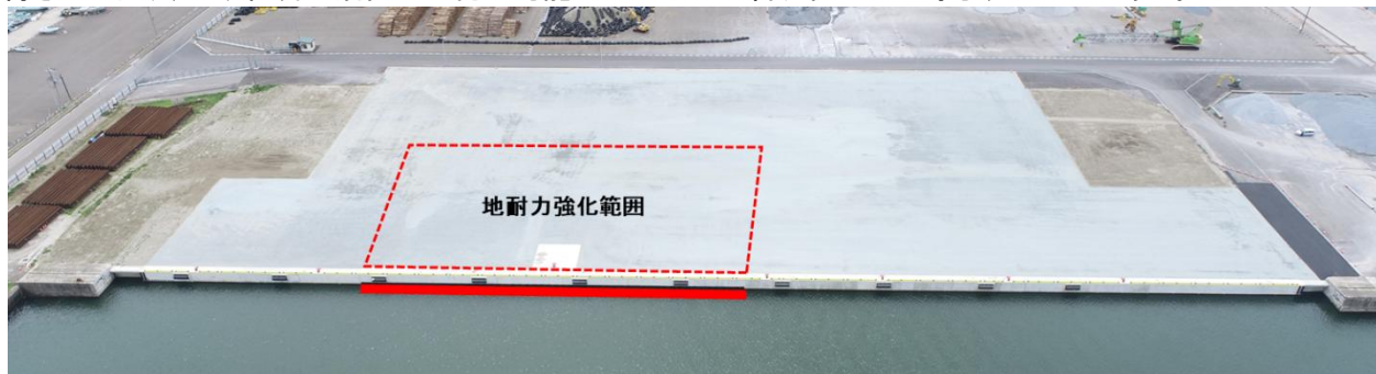
▲能代港大森地区岸壁(-10m)完成
