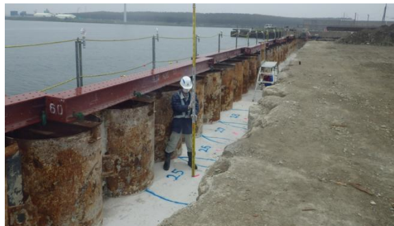
▲変位抑制対策(鋼管矢板の頭部連結)
