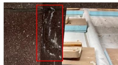
セメントスラリー注入後
