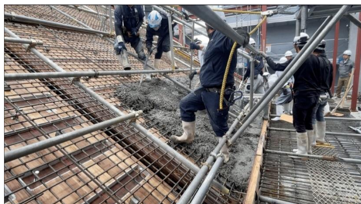
斜め TCC スラブの打設の様子
