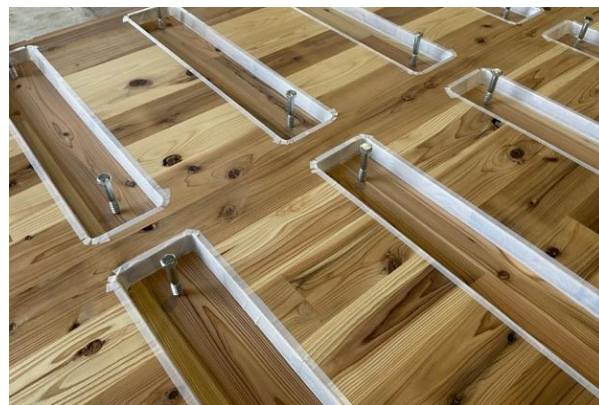
CLT はコッター(溝)とラグスクリューボルトによりコンクリートと一体化される
