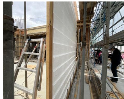
化粧型枠の施工
