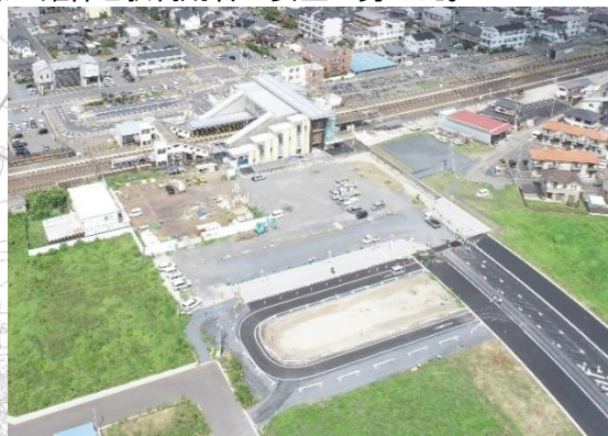
▲駅と駅前広場の施工中の様子と暫定ロータリー
