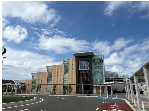
▲佐和駅東西自由通路及び新駅舎 東側外観
