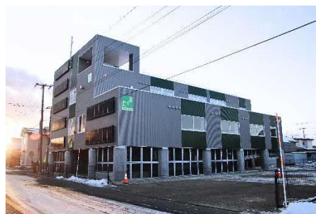
津波避難タワー(中園公園)
