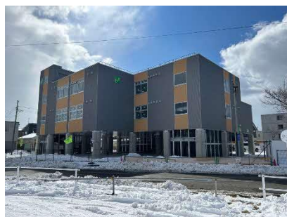
津波避難タワー(いづみ公園)
