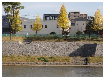
■布目崩しによる護岸整備
