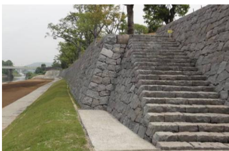
■算木積みによる護岸端部の施工
