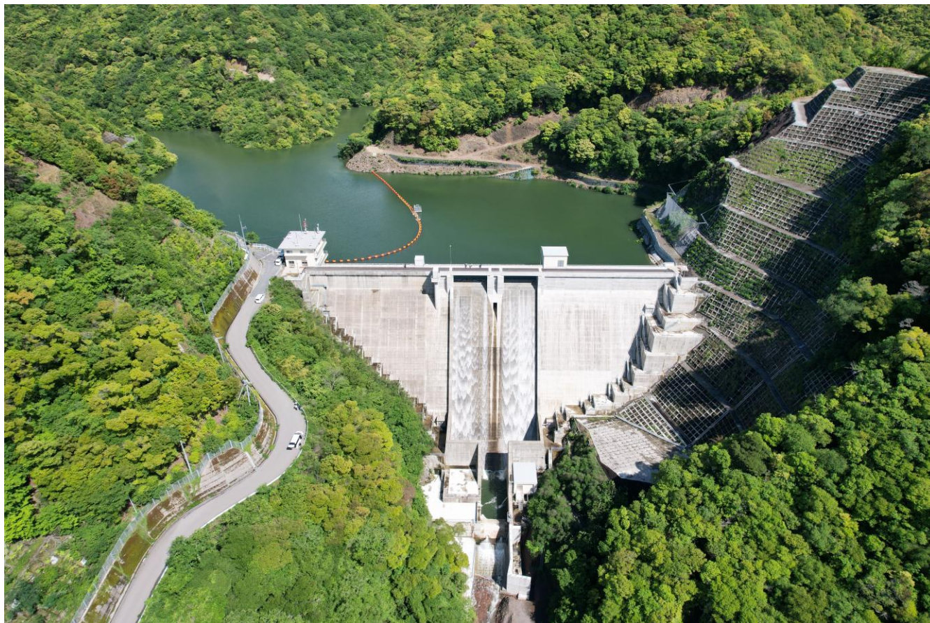
令和 7 年 5 月 25 日 試験湛水による目標水位到達時の写真
