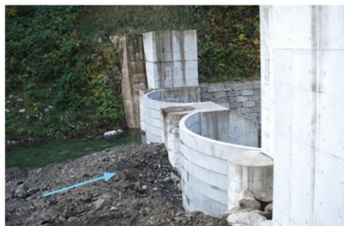
施工当時の笹生川第三堰堤
