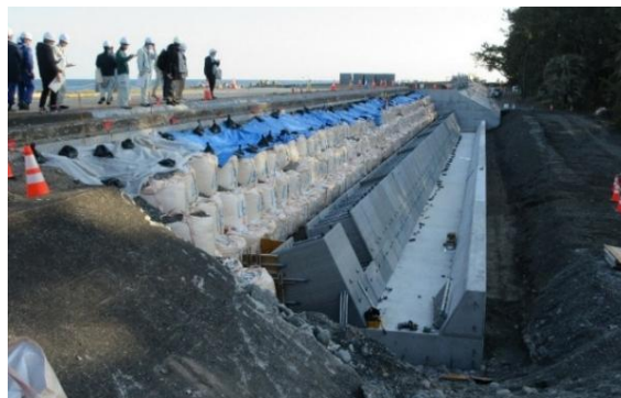
埋設型枠の据付の様子
