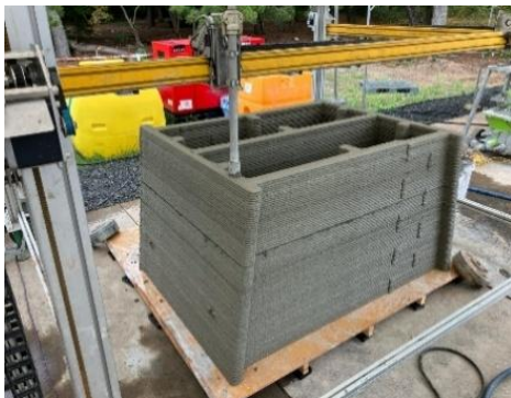
建設用 3D プリンターによる埋設型枠製作状況
