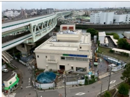
写真-1 王子第二ポンプ所(全景)
