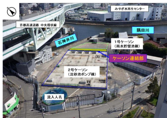
写真-5 王子第二ポンプ所(施工中)
