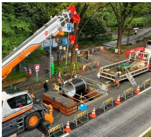
鋼管搬入の様子
