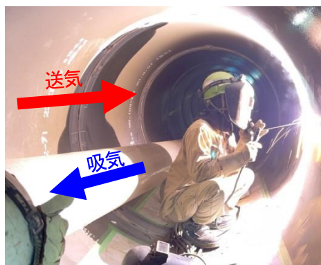
写真2 溶接時の管内換気状況
