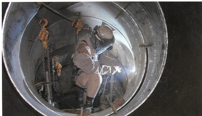
写真1 垂直配管における溶接状況
