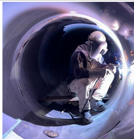
鋼管溶接の様子
