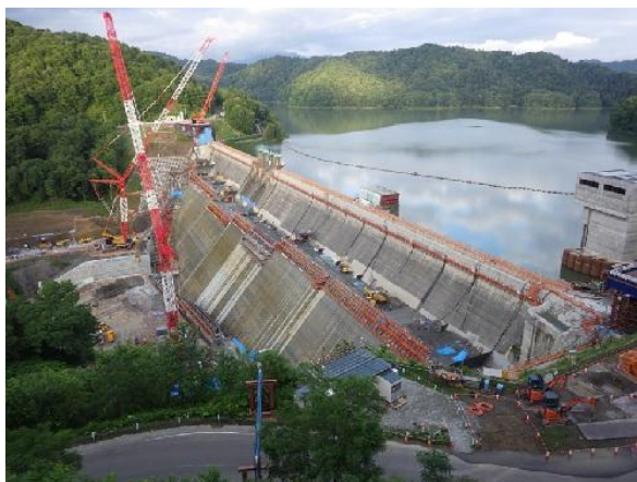
工事状況(H30.7)
