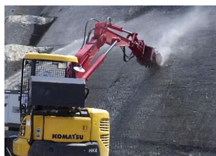
写真1 旧堤体コンクリートチップング状況
