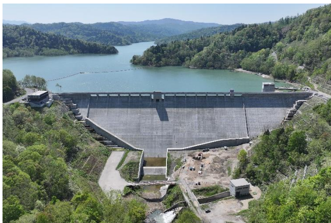
ダム竣工状況(R6.5)
