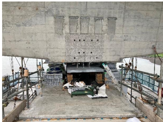
施工状況写真(橋脚部支保取替工)
