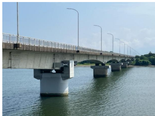
完成写真(起点側/左岸上流側)
