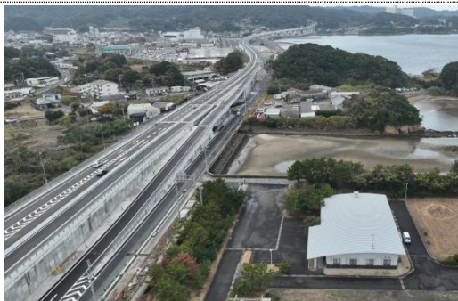
開通区間(松浦 IC 側～)
