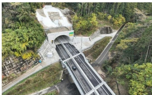
志佐(松浦1号)トンネル終点側抗口
