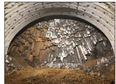
写真-3 切羽に出現した柱状節理玄武岩 終点坑口から320~440m付近
