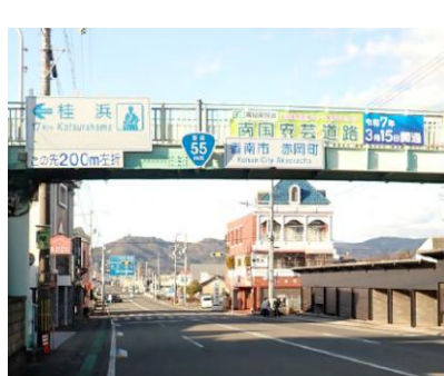
横断歩道橋(国道55号)に設置した横断幕
