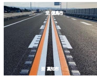
低炭素アスファルトを使用した舗装
