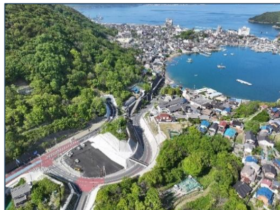
【トンネル供用後西側航空写真】
