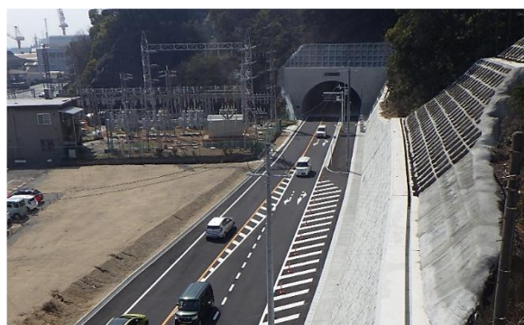
《 開削後 旧玉第一トンネル跡 》
