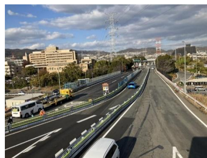
ランプ対面通行規制状況
