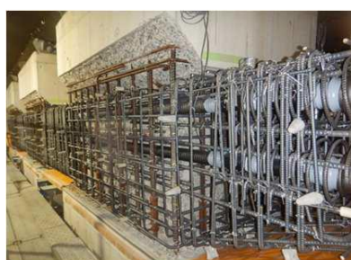
PRC 構造横梁施工状況
