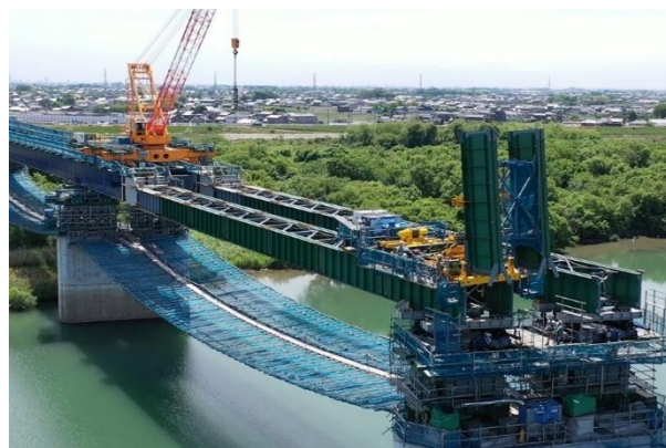
手延機解体状況
