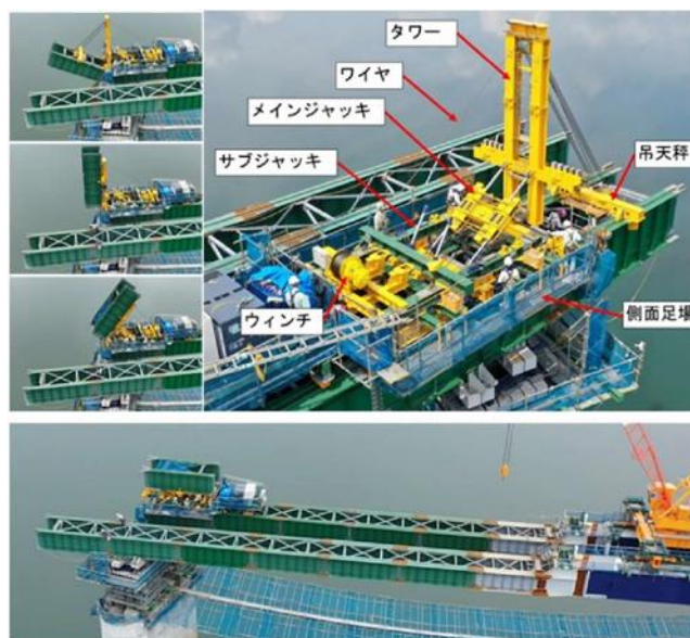
施工状況写真
