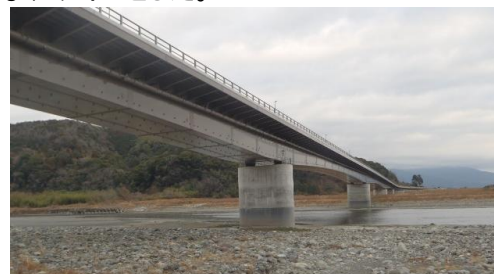
【施工後】右岸下流側から望む
