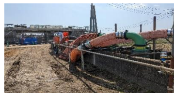
写真5 函渠施工時の大型ポンプ
