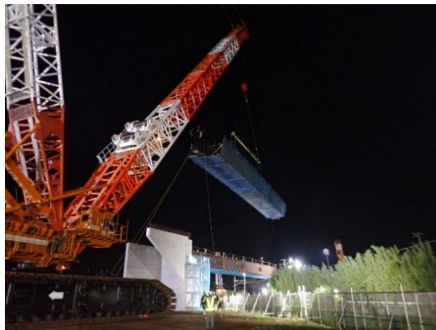
写真6 夜間クレーン架設状況
