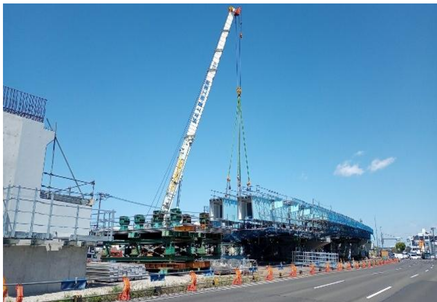
▲側径間のクレーンベント架設
