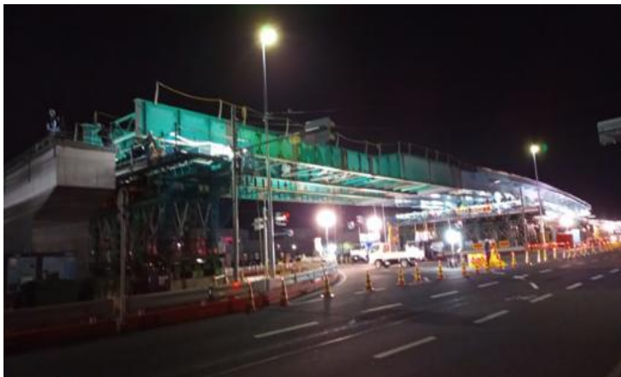
▲中央径間(交差点)の送り出し架設
