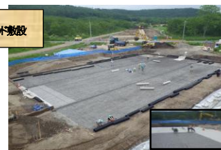
ボックスカルバート完成
