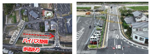
市道岡城線【阿蔵工区】バイパス整備
