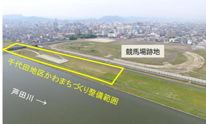
整備前の状況(全景)
