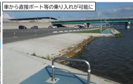
スロープ護岸
