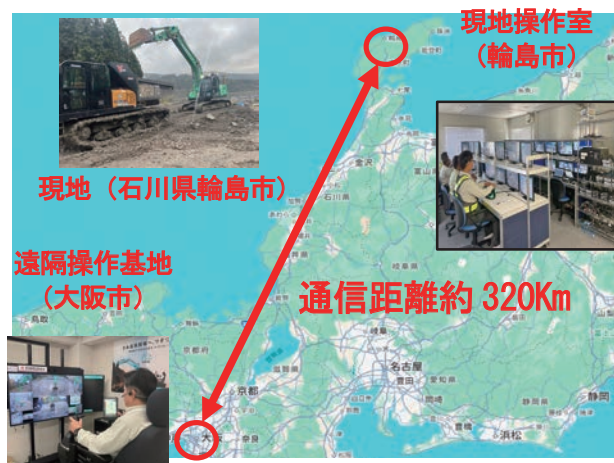
砂防工事における県外からの長距離遠隔操作
