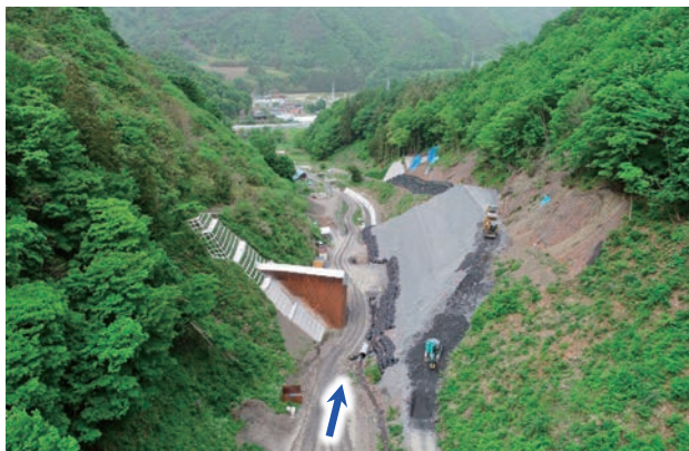
施工状況（応急押え盛土）
