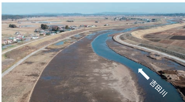
河道掘削完了（大郷大橋付近）
