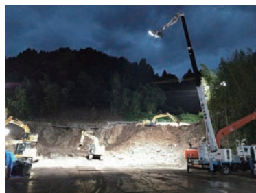
夜間の施工状況
