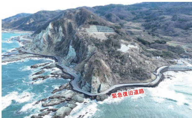
完成した緊急復旧道路
